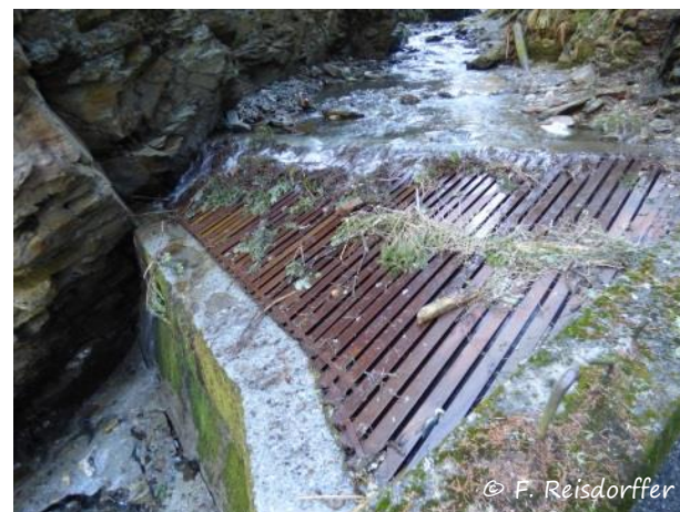
Prise d'eau constituant un seuil
