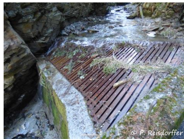
Prise d'eau constituant un seuil
